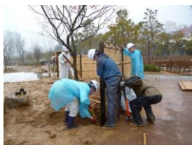
建仁寺垣の建込み
