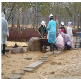
延段の石据え付け
